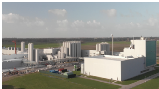
Fonterra Verduurzaming van droogtorens met warmteterugwinning en warmtepompen.
